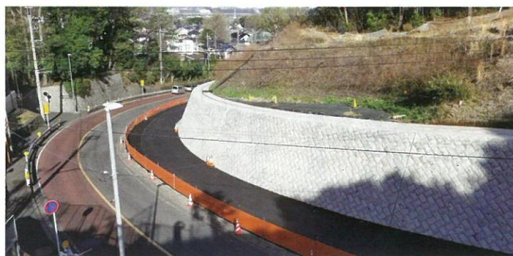
また、現在の片側歩道(幅員2m)を、両側歩道(3m)に整備する工事を進めるとともに、車道部分の舗装打ち換え工事は令和3年度末までの完成を目指しております。
