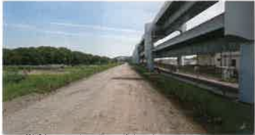
さがみグリーンライン工事箇所
