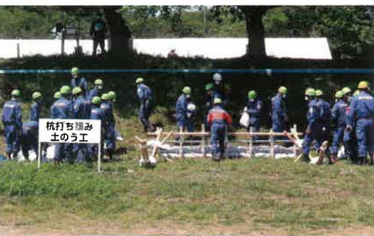
杭打ち積み土のう工
