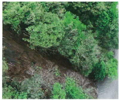
ドローンで撮影した被害状況
